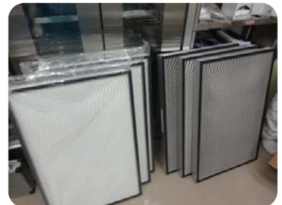
消耗品交換(HEPAフィルター)
