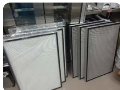
消耗品交換(HEPAフィルター)
